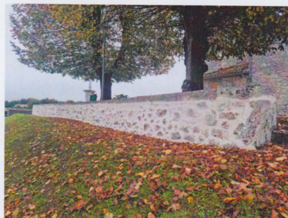
Murette de l'église du Laurier
